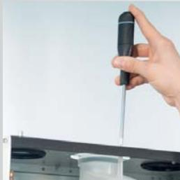
Rimozione vite blocco collettore fumi
