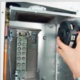
Rimozione del sistema di combustione completo
